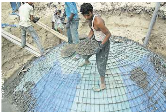
Ein Beispiel für das Engagement der Stiftung Allianz für Entwicklung und Klima und ihrer Unterstützer ist der Bau von Kleinbiogasanlagen in Nepal, mit denen CO 2 eingespart wird.
